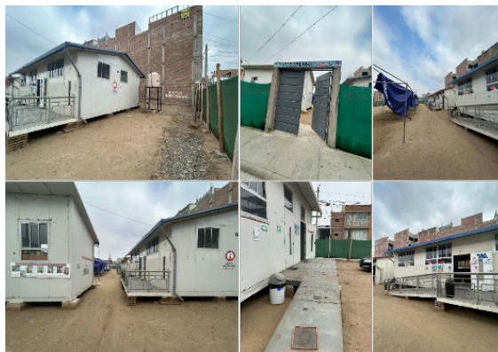
FIGURA N°02: Registro fotográfico del ingreso a la infraestructura del EBE
