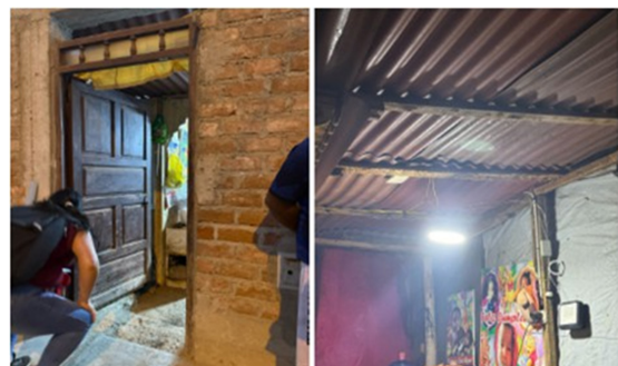
Figura N°04 : Fotografía mostrando la estructura exterior e interior de una vivienda-comercio.
