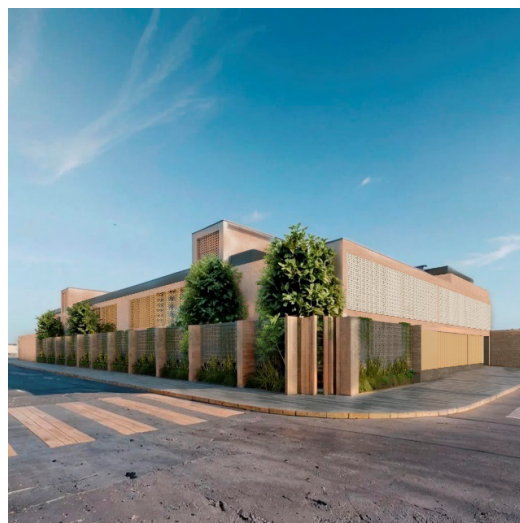
Figura 10: Vista esquina fachada posterior
