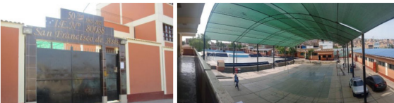
FIGURA N°01: Fachada y Pabellón de la I.E. San Francisco de Asís
