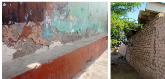
FIGURA N°05: Vista interior y exterior del muro de contención
