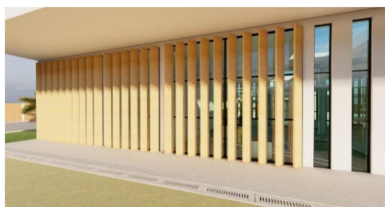
Figura 9. Parasoles verticales distribuidos en la fachada
